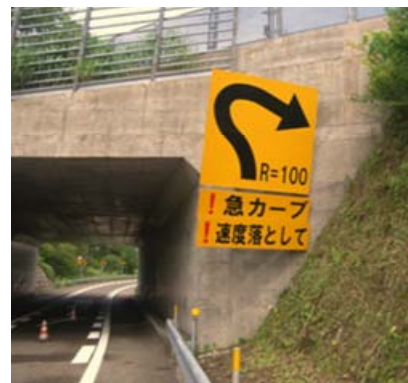
急カーブ注意喚起看板(6か所設置)
