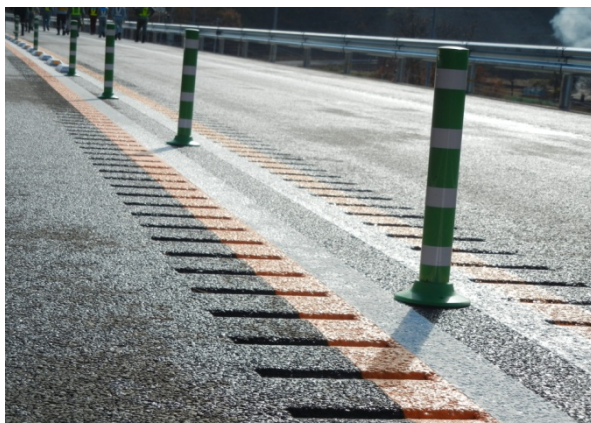
暫定2車線区間の凹凸型路面標示 (平成26年度約27km施工(上下計))
